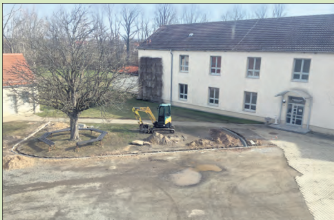
◀ Schwalbenpfütze im Bau.
